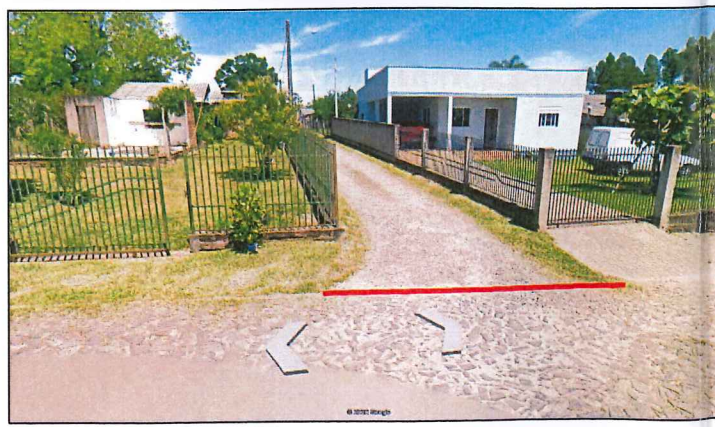
FINAL DO PAVIMENTO - ESTACA KM 00+136,15m
