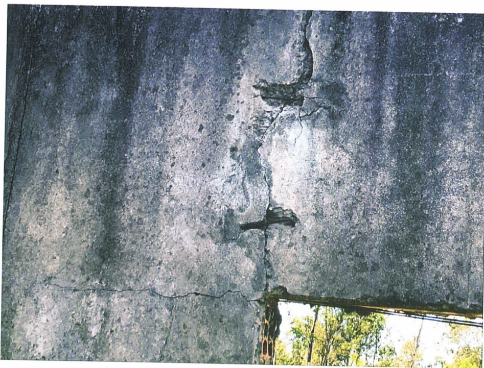
Foto 3: Obra paralisada da E.M.E.F. 8 de Dezembro, onde mostra as paredes das salas de aulas rebocadas, mas precisando de algumas correções e limpeza.
