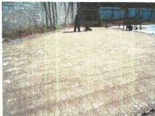
FOTO: 05, Salgamento com areia p/fixação e Compactação do PAVs
