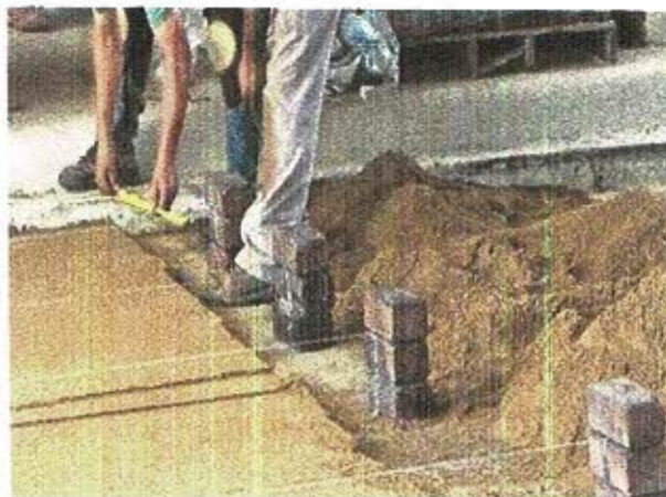
FOTO: 03, Colchão de Areia para assentamento PAVs.
