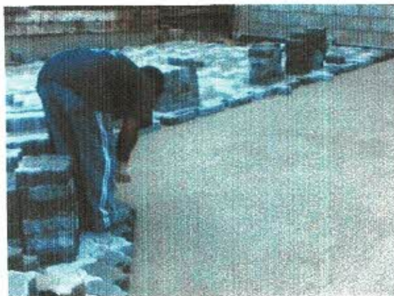
FOTO: 04, Assentamento dos PAVs.
