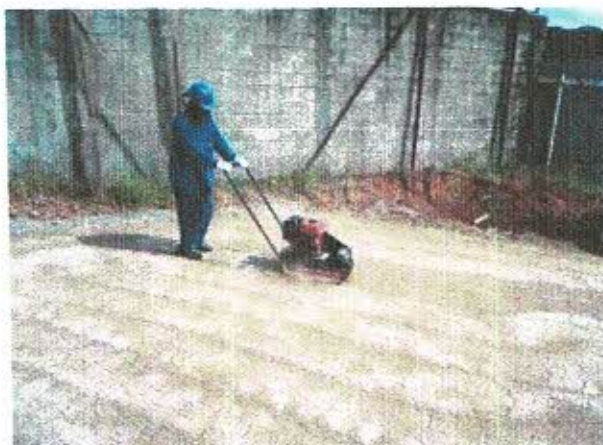
FOTO: 06, Compactação do PAVs
