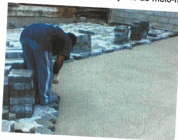
FOTO: 04, Assentamento dos PAVs.
