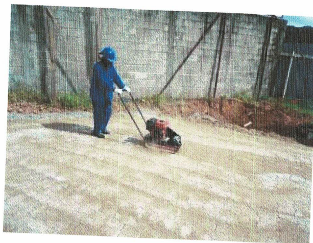
FOTO: 06, Compactação do PAVs
