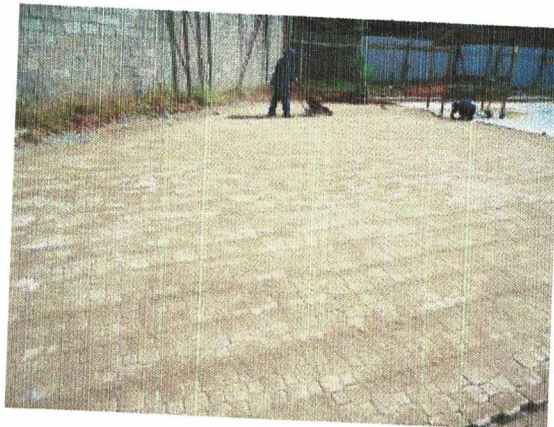
FOTO: 05, Salgamento com areia p/fixação e Compactação do PAVs
