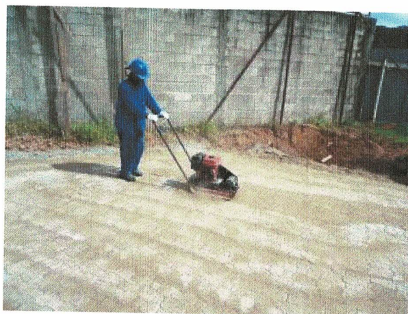
FOTO: 10, Compactação do PAVs
