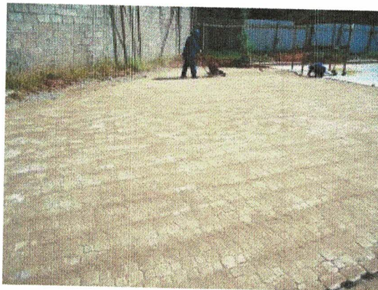
FOTO: 9, Salgamento com areia p/fixação e Compactação do PAVs
