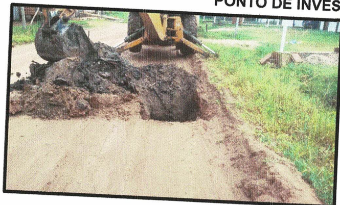
FOTO:3 Material escavado
