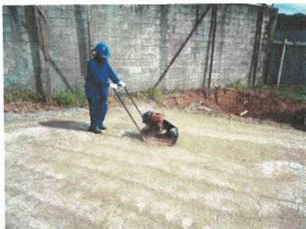
FOTO: 10, Compactação do PAVs
