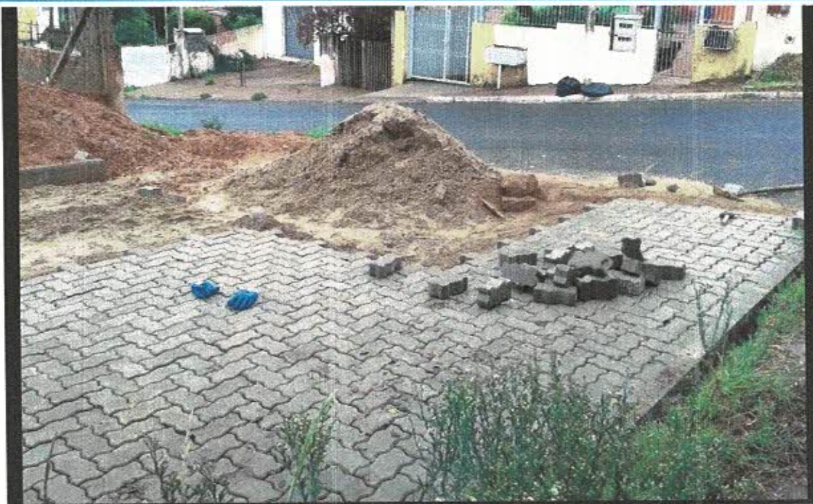
FOTO: 6, Foto do calçamento de rua urbana.
