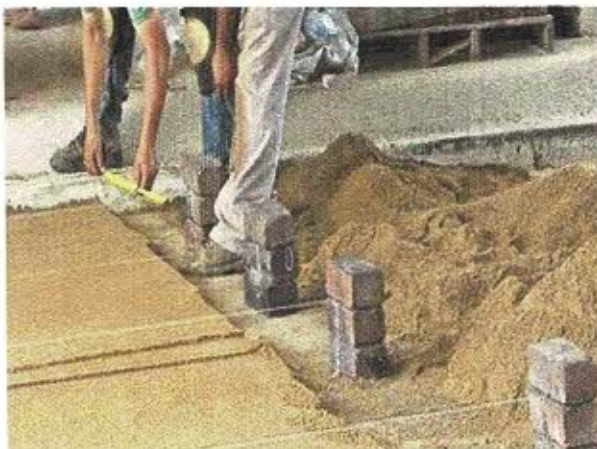
FOTO: 7, Colchão de Areia para assentamento PAVs.
