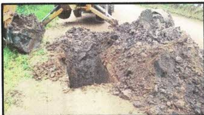
FOTO:1 Material escavado
