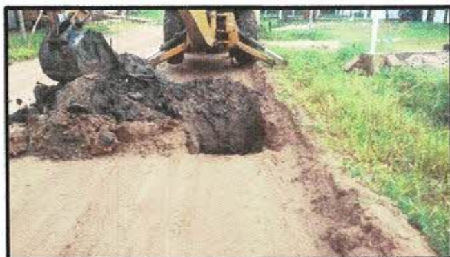
FOTO:3 Material escavado
