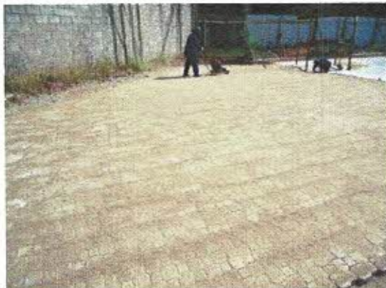
FOTO: 9, Salgamento com areia p/fixação e Compactação do PAVs
